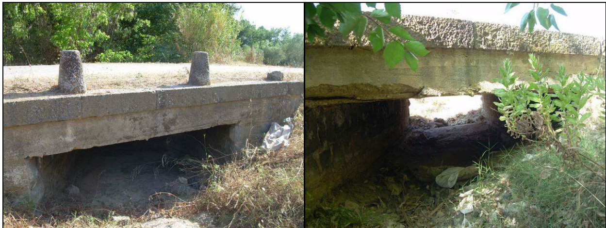
Figura 4-6: ponte sul Riu Perda Ghiani della "Strada Comunale di Monte Perdosu"
