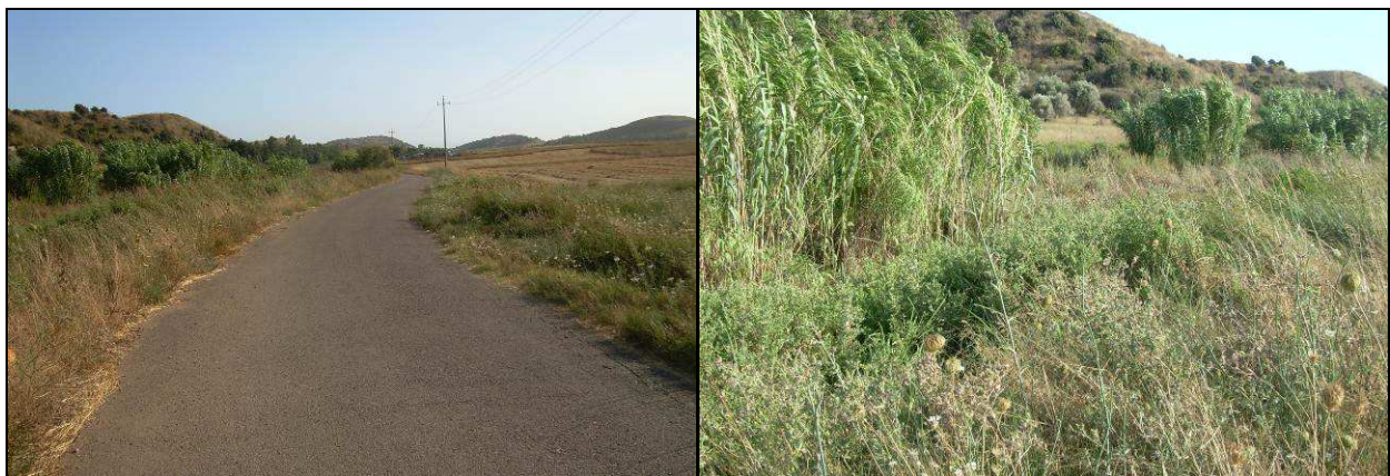
Figura 4-10: alveo del Riu Canneddu e stradello sulla sua destra idraulica
