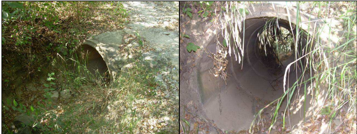
Figura 4-8: tratto intubato immediatamente a valle del ponte sulla strada comunale.
