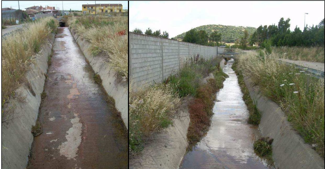
Figura 3.6: canale de Is Tramazeddus a valle della Nuova zona C di Via Togliatti
